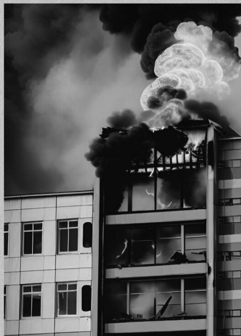
El incendio del edificio Harding, esta madrugada
